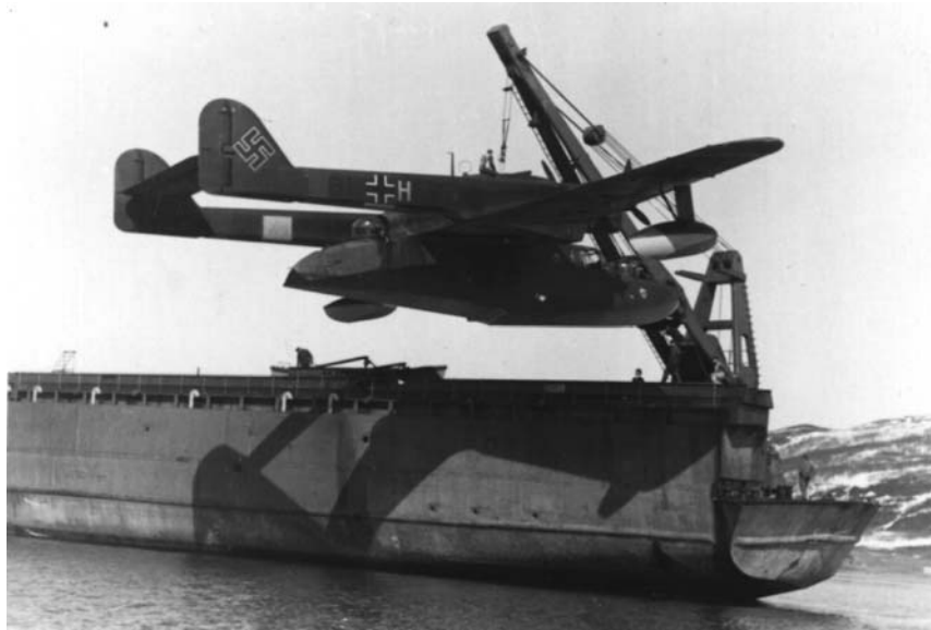
Der Kampnagelkrah hebt das Flugboot wieder auf die Startbahn
