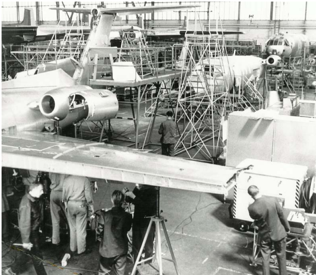
1963 Endmontage der HFB 320 V1 und V2 in der Halle 1
